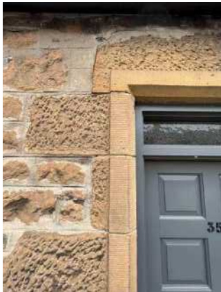
006 front door jamb/lintel stone detail
